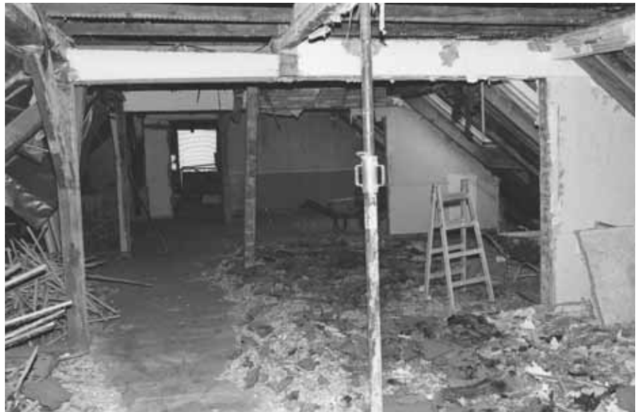
Der ‚D-Zug‘ wird entkernt
